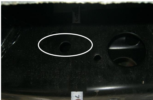
Рис.4 Установка шпильки закладной для крепления заднего кронштейна
