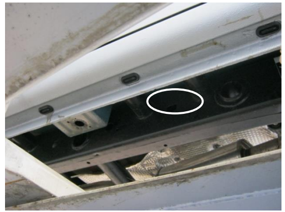
Рис.3 Установка шпильки закладной для среднего кронштейна
