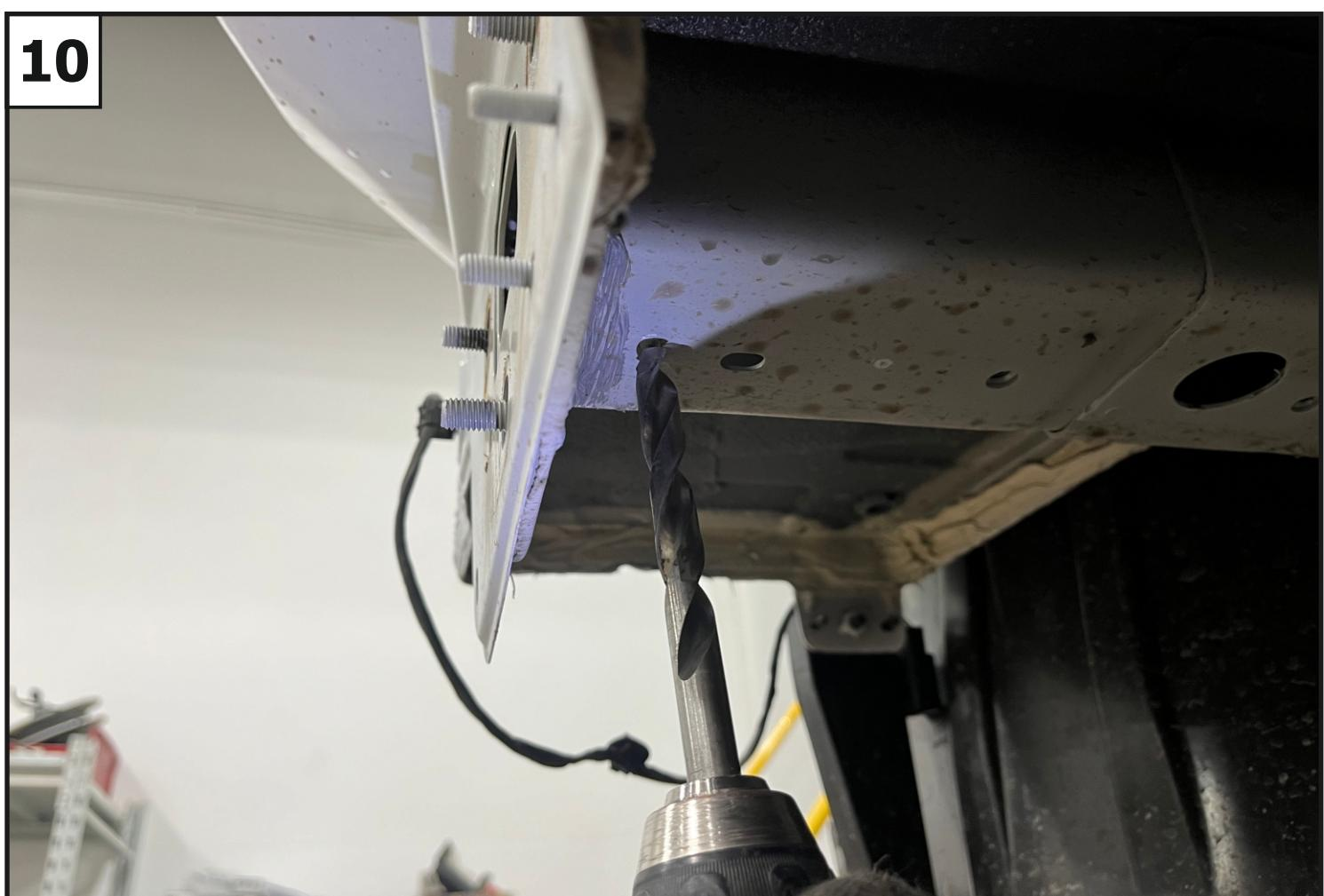
Просверлить отверстия сверлом Ø 12 мм. С другой стороны аналогично
